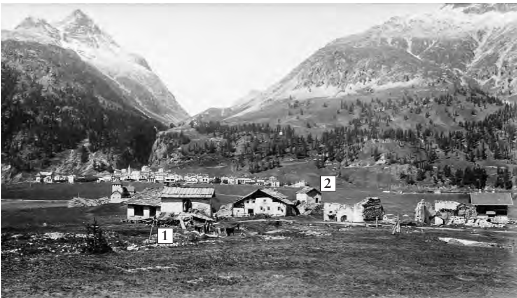
Abb. 185: Silvaplana, Surlej, vor 1900. Ansicht von Osten. 1 Der im Haus Lutz eingeschlossene mutmassliche Speicher 2 Der von Christoph Simonett als Kornspeicher identifizierte Bau auf dem Felsblock. Links und rechts davon stehen traditionelle, teilweise verfallene Bauernhöfe mit angebautem Stall
