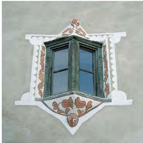
Abb. 109: Scuol, Haus Nr. 82. Details der restaurierten Fassade.
