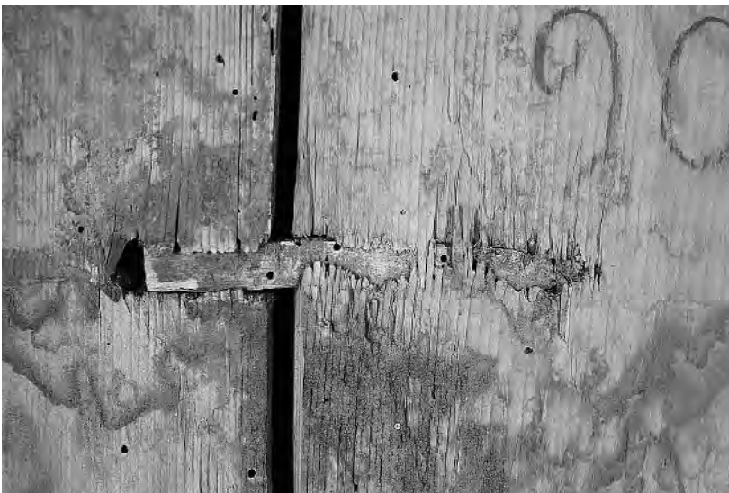
Abb. 121: Zillis-Reischen, Kirche St. Martin, Bilderdecke, Tafel 69. Rückseitig sichtbare, originale Verdübelung mit einem geschnittenen Holzdübel.
