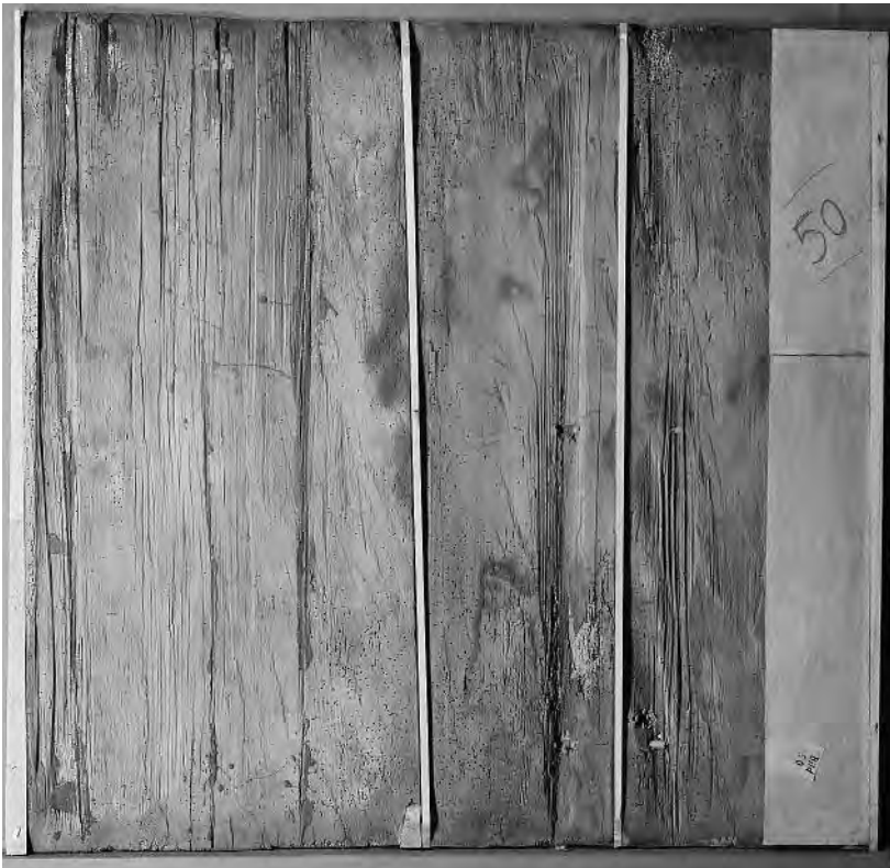
Abb. 120: Zillis-Reischen, Kirche St. Martin, Bilderdecke, Tafel 50. Streiflichtaufnahme der Rückseite, welche die beim Spalten der Bretter entstandenen Bearbeitungsspuren und Vertiefungen durch ausreissende Fasern sichtbar werden lässt. Ebenso zu erkennen sind die geglätteten Bereiche (flache Stellen). Anstückungen, Fugenleisten sowie Holzverstärkungen mit Sperrholz stammen von der Restaurierung 1938-41, ebenso die Holz Sicherungen, welche als verdunkelte, leicht glänzende Stellen in Erscheinung treten. Am rechten, originalen Brettteil ist eine aufgebrochene Stelle mit starkem Insektenbefall zu erkennen.
