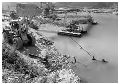
Abb. 86: Untervaz, Kiesgrube. Martin Weber bei der Freilegung und Bergung der verbauten Hölzer. Mit Hilfe eines Baggers werden die Balken herausgezogen. Blick gegen Südwesten.
