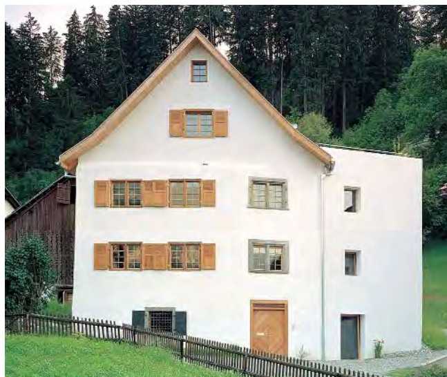
Cazis, Haus Pajarola - Ein Haus zum Wohnen und Arbeiten
