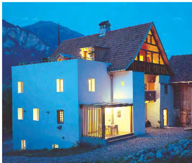
Abb. 166: Cazis, Haus Pajarola. Ostfassade.
