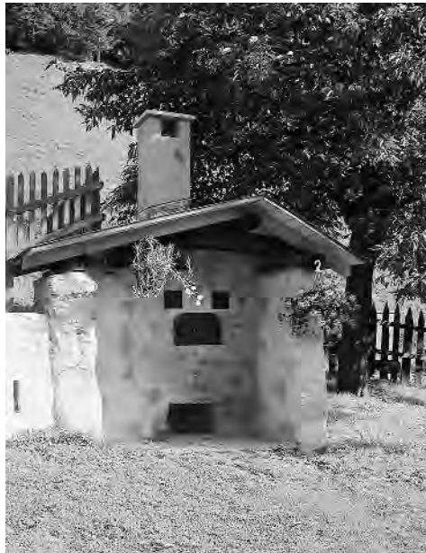
Abb. 104: Schlans, Backhaus Weber.
