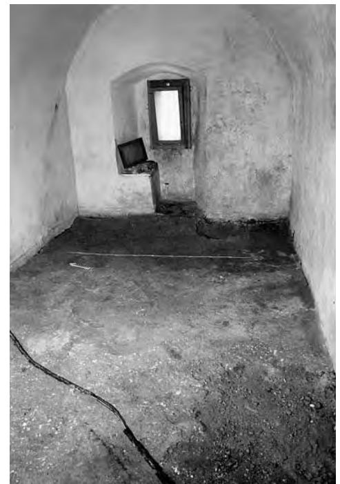
Abb. 54: Castrisch, evangelische Kirche. Mörtelboden in der Sakristei. Blick gegen Osten.
