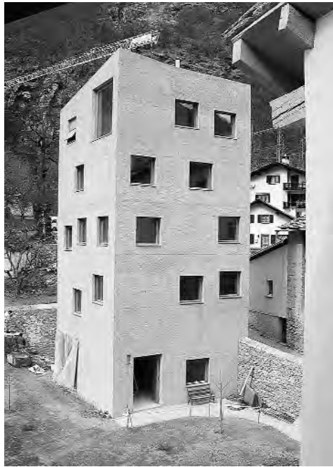
Abb. 152: Castasegna, Villa Garbald. Neubau für die ETHZ-Aussenstelle im Garten der Villa Garbald, Rohbauzustand 2003.
