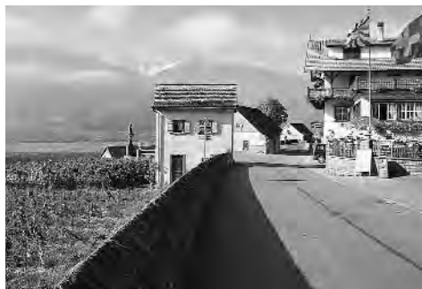
Abb. 164: Jenins, Rebhaus Nr. 62. Ansicht von Süden.
