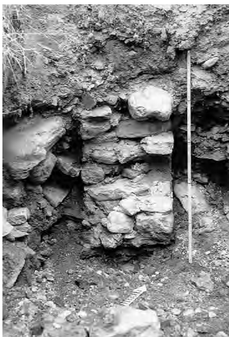
Abb. 59: Küblis, Obergasse. Mauerbefund in Schnitt 1. Blick gegen Nordwesten.
