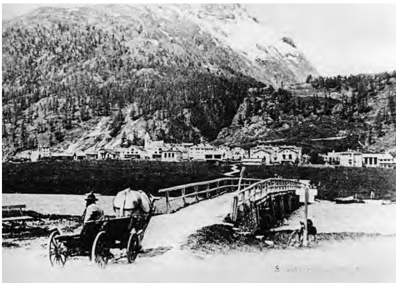
Abb. 73: Silvaplana, Brücke Surlej. Die Fotografie zeigt die 1811 reparierte oder erneuerte Brücke. Aufnahme um 1880. Blick gegen Norden.
